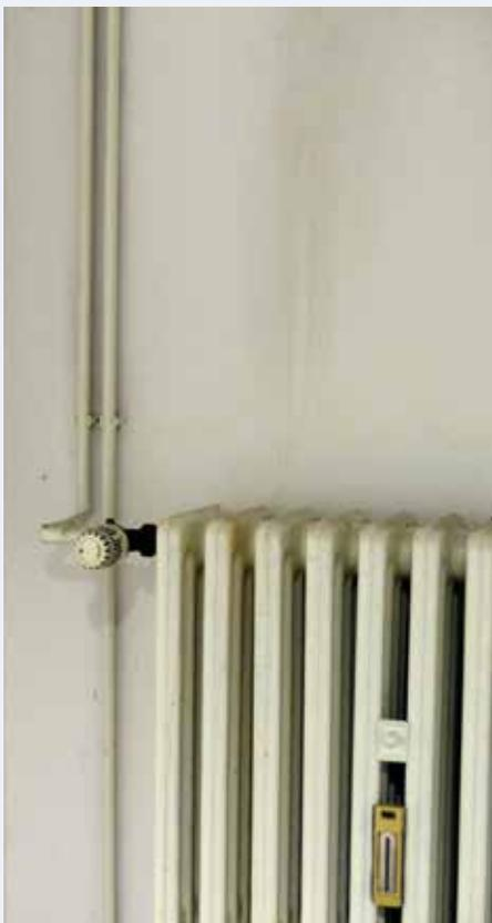
Wenn, wie hier, Heizungsrohre über weitere Strecken über Putz verlaufen und nicht isoliert sind, ist ein Rohrwärmefall wahrscheinlich.
